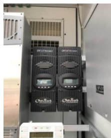
Figura 4. Reguladores utilizados en el proyecto
